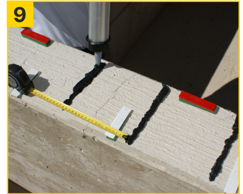
9 Adheseal mit Nozzle 600 ml V-Form 8 × 8 und einem Kleberauppenabstand von 20 cm auf Untergrund auftragen.
