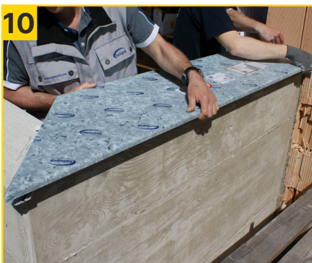
10 Helopal Fensterbank bzw. Mauerabdeckung innerhalb von 8 Min. (inkl. einrichten) montieren. Durch beschweren, die Teile 24 Std. gegen Wind- & Soglasten schützen.
