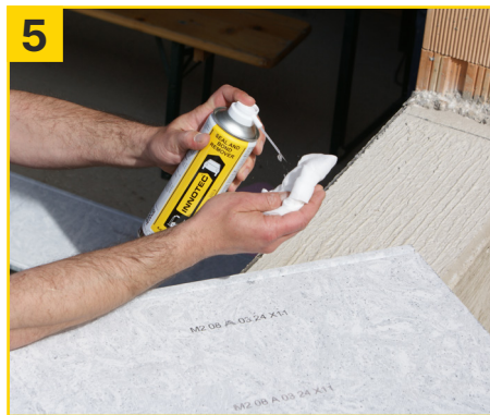
5 Helopal Fensterbank bzw. Mauerabdeckung mit Seal and Bond Remover und Multi Wipes entfetten (mind. 5 Min. ablüften lassen).
