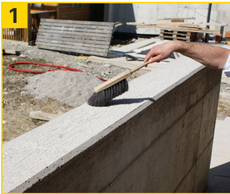
1 Den Untergrund staubfrei machen... (Wichtig: Der Untergrund darf nicht porös sein - ggf. mit grober Bürste und/oder Hochdruckreiniger poröse Teile des Betons entfernen)
