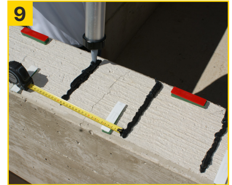
9 Adheseal mit Nozzle 600 ml V-Form 8 × 8 und einem Kleberaunenab- stand von 20 cm auf Untergrund auftragen.
