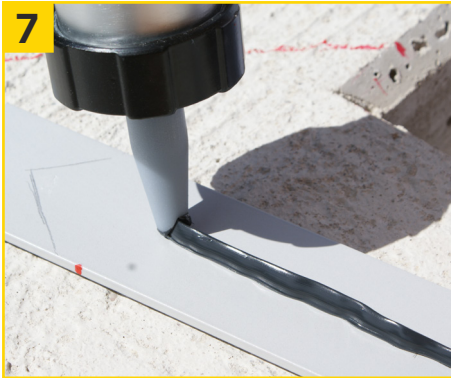
7 Adheseal auf Stoßverbinder / Rillen- profile auftragen...
