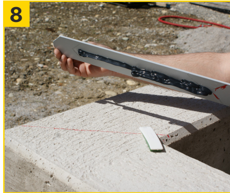
8 ... und anschließend innerhalb von 8 Min. (inkl. einrichten) verkleben.
