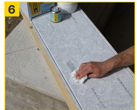
6 Seal Guard mit Hilfe eines Multi Wipes auf Helopal Fensterbank bzw. Mauerabdeckung dünn auftragen und mind. 15 Min. ablüften lassen (max. 4 Std.).
