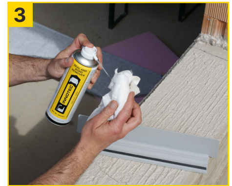
3 Stoßverbinder/Rillenprofile mit Seal and Bond Remover und Multi Wipes entfetten (mind. 5 Min. ab-lüften lassen).
