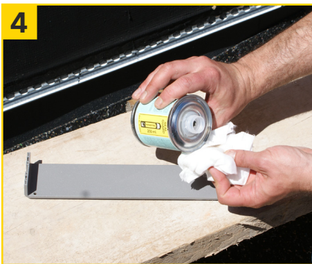
4 Seal Guard mit Hilfe eines Multi Wipes auf Stoßverbinder/Rillenprofile dünn auftragen und mind. 15 Min. ablüften lassen (max. 4 Std.).
