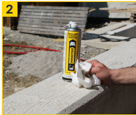
2 ... und anschließend mit Seal and Bond Remover und Multi Wipes entfetten (mind. 5 Min. ablüften lassen).
