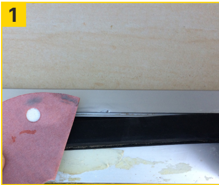
1 Grat mit ICECUT Discs (K320) entfernen.
