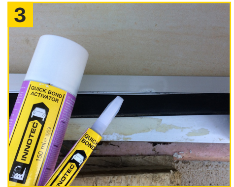
3 Kratzer mit Quick Bond auffüllen und Quick Bond Activator zum sofortigen Aushärten aufsprühen.
