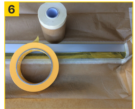
6 Umliegende Flächen mit SunCore Pro und Taiga Blue Core abkleben.
