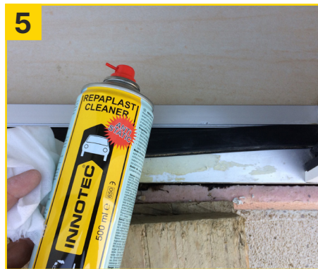
5 Untergrund wieder mit Repaplast Cleaner Antistatic und Multi Wipes gut reinigen (ca. 5 Min. ablüften lassen).
