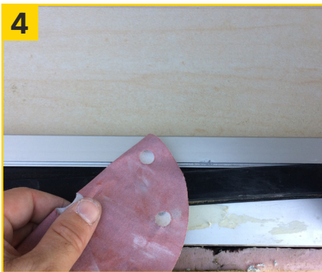
4 Nochmals mit ICECUT Discs (K320 + K500) Quick Bond plan (eben) schleifen.
