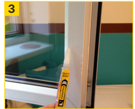
3 Abschürfung / Druckstelle / Kratzer mit Quick Bond auffüllen. Quick Bond Activator zum sofortigen Aushärten aufsprühen.
