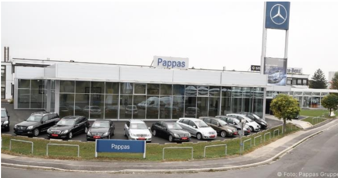
Pappas Automobilvertriebs GmbH in Linz – seit 40 Jahren Arbeitsplatz von Thomas Berger.
