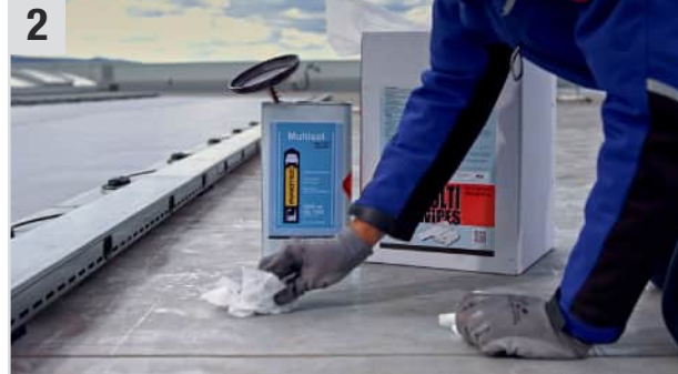
2 Klebebahnen mit mit Multisol (Entfetter / Reiniger) und Multi Wipes (Universaltuch) gut reinigen und mit trockenen Multi Wipes nachwischen (ca. 10 Min. ablüften lassen).
