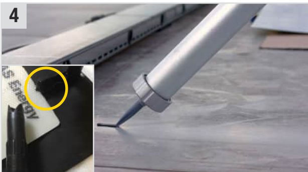
4 Versabond Schwarz mit der Accu Silicon Pistole 10,8 V (Akku-Pistole) und der Beutel-Spitze (V-Form 8 x 8 mm ▲) gleichmäßig entlang der gereinigten Bahnen auftragen.
