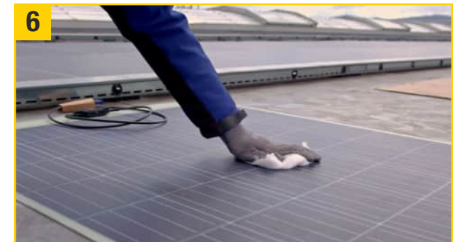
6 Das Photovoltaik-Modul mittels Multi Wipes (Universaltuch) an den Klebestellen andrücken (punktuelle Belastungen sollen vermieden werden, da ansonsten Zellenbrüche entstehen können). Fertig!
