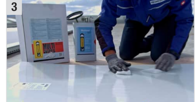
3 Die Rückseite des Photovoltaik-Moduls mit Multisol (Entfetter / Reiniger) und Multi Wipes (Universaltuch) gut reinigen und mit trockenen Multi Wipes nachwischen (ca. 10 Min. ablüften lassen). Die Vorderseite des Photovoltaik-Moduls darf hierbei nicht auf einem scharfen oder kantigen Untergrund liegen (um Beschädigungen des Moduls zu vermeiden).
