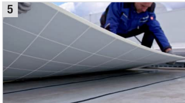
5 Das Photovoltaik-Modul vorsichtig auf die Kleberaupen legen.
