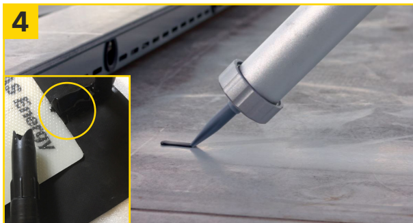
4 Versabond mit der Accu Silicon Pistole 10,8 V und der Beutel-Spitze (V-Form 8 × 13 mm ▲) gleichmäßig entlang der gereinigten Bahnen auftragen.
