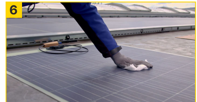
6 Das PV-Modul mittels Multi Wipes Project an den Klebestellen andrücken (punktuelle Belastungen sollen vermieden werden, da ansonsten Zellenbrüche entstehen können).
