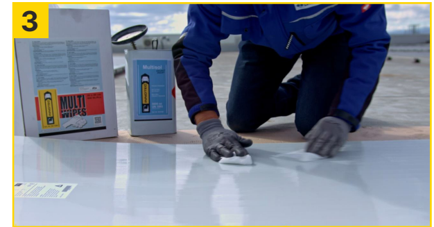
3 Die Rückseite des PV-Moduls mit Multisol Project und Multi Wipes Project gut reinigen und mit trockenen Multi Wipes Project nachwischen (ca. 10 Min. ablüften lassen).
