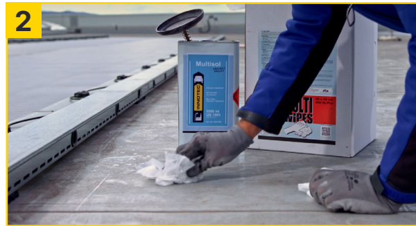
2 Klebahnen mit Multisol Project und Multi Wipes Project gut reinigen und mit trockenen Multi Wipes Project nachwischen (ca. 10 Min. ablüften lassen).
