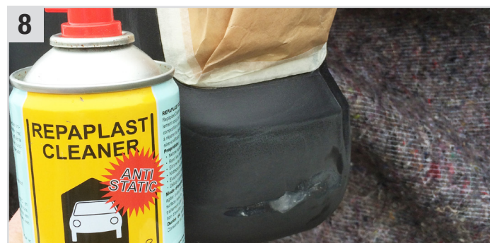
Die zu behandelnde Stelle nochmals mit Repaplast Cleaner Antistatic (Kunststoff-Reiniger) und Multi Wipes Tuch (Universaltuch) reinigen (ca. 5 Min. ablüften lassen).
