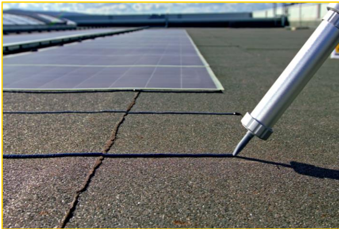
Photovoltaik- und Fassadenverklebung
