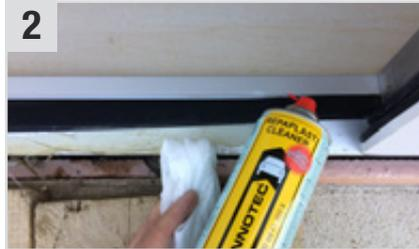
Untergrund mit **Repaplast Cleaner Antistatic** (Kunststoff-Reiniger) und **Multi Wipes Box** (Universaltuch) gut reinigen (ca. 5 Min. ablüften lassen).
