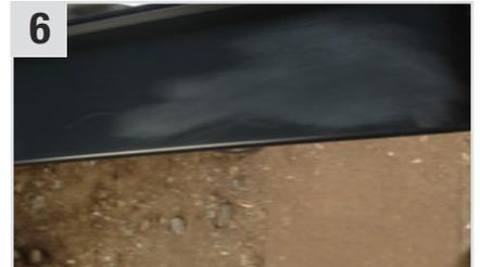
Mit **Shine P 600** abziehen und mit **Multi Wipes Box** (Universaltuch) den feinen Schleifstaub entfernen.
