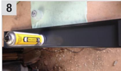
2 deckende Schichten **Repaplast Colour Finish Better Care Rauchgrau (5031)** (Kunststofflack) auftragen (ca. 10 Min. trocknen lassen).
