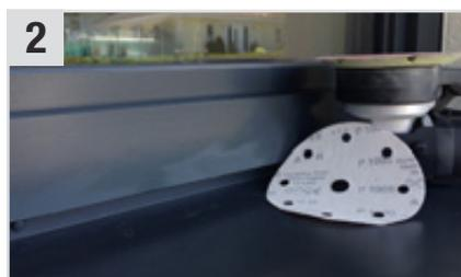
2 Mit **Royalcut** (Schleifpapier) - **K 800 / K 1000** Rückstände des Montageschaums entfernen (even. nass schleifen).
