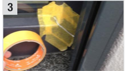
Umliegende Flächen mit **SunCore Pro** (Abdeckband) abkleben.
