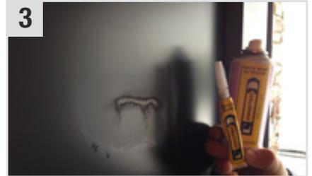
Kratzer mit **Quick Bond** (Sekundenkleber) auffüllen und **Quick Bond Activator** (Sekundenkleber-Beschleuniger) zum sofortigen Aushärten aufsprühen.
