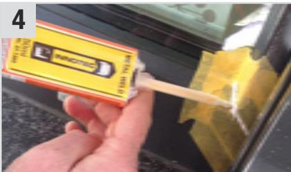
Mit **Metal Weld** (2K Metallkleber) Riss füllen.
