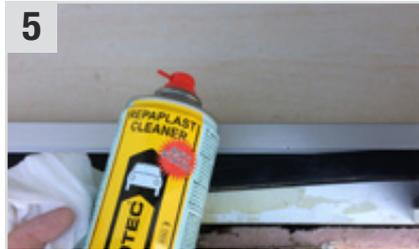
Den Untergrund wieder mit **Repaplast Cleaner Antistatic** (Kunststoff-Reiniger) und **Multi Wipes Box** (Universaltuch) gut reinigen (ca. 5 Min. ablüften lassen).
