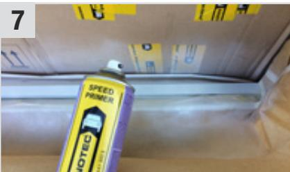
**Speed Primer Weiß (0000)** (Grundierungs- und Füllerspray) in einer deckenden Schicht auftragen (ca. 20 Min. trocknen lassen).
