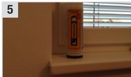
5 Dünne Schicht **Repaplast Primer New Formula** (Kunststoff-Haftvermittler) auftragen (ca. 10 Min. ablüften lassen).
