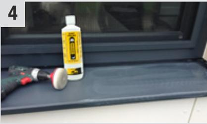
Mit **Easy Polish** (Lackreiniger / Versiegelung - Gelb) und **Spot Pad Foam** (Polierpad (PU-Schaum) mit Klettverschluss) beschichtete Oberfläche aufpolieren und mit **Clean & Shine Towel** (Wabenstrukturtuch) nachpolieren.
