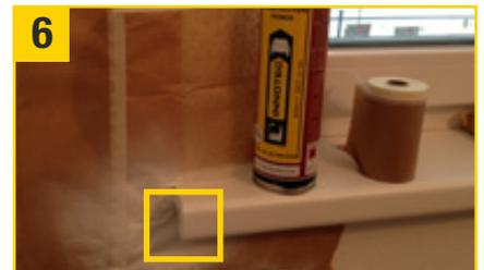
6 **Masking Paper** (Abdeckpapier) / **SunCore Pro 24 mm** (Abdeckband) an die gewünschten Stellen aufkleben und 2 deckende Schichten **Construction Primer Weiß (0100)** auftragen (ca. 20 Min. trocknen lassen) - **Fertig!**
