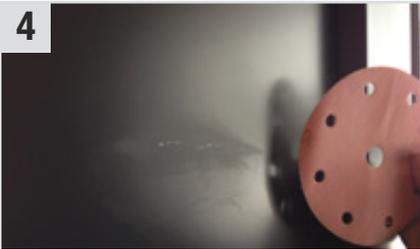
Nochmals mit **Schleifpapier - K 400 / K 500** Quick Bond (Sekundenkleber) plan (eben) schleifen und mit **K 600** nachschleifen.
