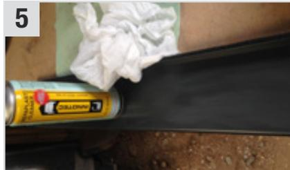
Den Untergrund wieder mit **Repaplast Cleaner Antistatic** (Kunststoff-Reiniger) und **Multi Wipes Box** (Universaltuch) gut reinigen (ca. 5 Min. ablüften lassen).
