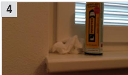
4 Den Untergrund wieder mit **Repaplast Cleaner Antistatic** (Kunststoff-Reiniger) und **Multi Wipes Box** (Universaltuch) gut reinigen (ca. 5 Min. ablüften lassen).
