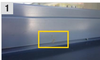
1 Beschichteter Rahmen bei Fensterstock durch Montageschaum vollständig verschmutzt.
