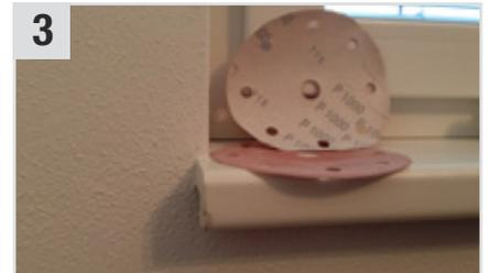
3 Mit **Royalcut** (Schleifpapier) - **K 320 / K 400** Quick Bond (Sekundenkleber) plan (eben) schleifen und Übergang mit **K 500** aufrauen.
