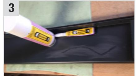
Kratzer mit **Quick Bond** (Sekundenkleber) auffüllen und **Quick Bond Activator** (Sekundenkleber-Beschleuniger) zum sofortigen Aushärten aufsprühen.
