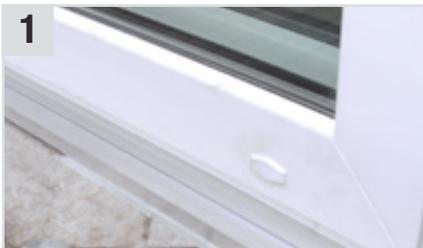
Untergründe vor dem Verfugen mit **Seal and Bond Remover** (Klebstoff- & Dichtmassenentferner) und **Multi Wipes Box** (Universaltuch) reinigen.
