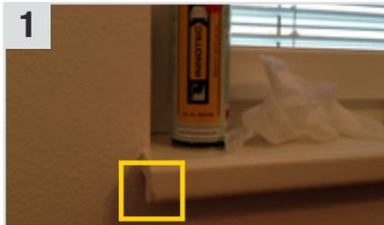
1 Untergrund mit **Repaplast Cleaner Antistatic** (Kunststoff-Reiniger) und **Multi Wipes Box** (Universaltuch) gut reinigen (ca. 5 Min. ablüften lassen).
