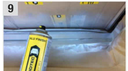
**Alu Finish** (Alulack - helleres Silber) in mehreren dünnen Schichten anbringen (Sprühabstand 25-30 cm) - zwischendurch 10 Minuten ablüften lassen.
