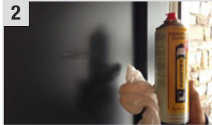
Untergrund mit **Repaplast Cleaner Antistatic** (Kunststoff-Reiniger) und **Multi Wipes Box** (Universaltuch) gut reinigen (ca. 5 Min. ablüften lassen).
