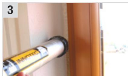
**Uniseal Fenster & Türen** mit der **Foil Pack Gun 600 ml** (Beutelpistole) mit einer Stärke von 2-3 mm auf Montage-Schaum auftragen!
