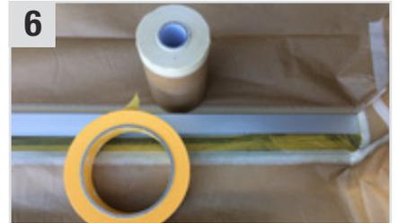
Umliegende Flächen mit **SunCore Pro** (Abdeckband) und **Masking Paper Dispenser** (Abdeckpapier) abkleben.
