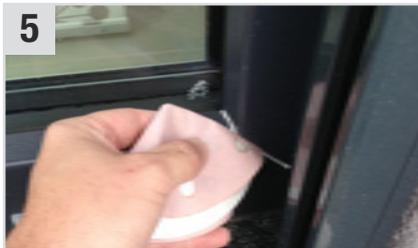
Nach ca. 30 Min. mit einer Maschine oder händisch schleifen (**K 220**, **K 320**, **K 400**).
