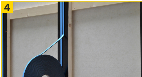
Fixation Tape 3 Project auf der Unterkonstruktion anbringen (dabei gut andrücken) und die Folie anschließend entfernen.
