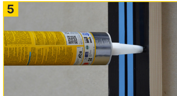
Adheseal Project parallel zum Klebeband (mind. 5 mm Abstand zwischen Fixation Tape 3 Project und Adheseal Project mit der mitgelieferten Spitze auftragen (8 mm-Raupe).
