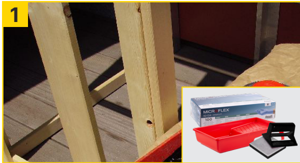
Holz-Unterkonstruktion (Fichtenholz gehobelt nach ÖNORM B 4100, Holzfeuchte: 14-18 %) Achsen-Abstand 40 - 50 cm!
