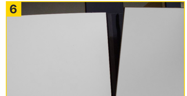
Innerhalb von 10 Minuten nach dem Auftragen des Klebers Fassadenplatte anbringen (dabei gut andrücken). Fertig!
