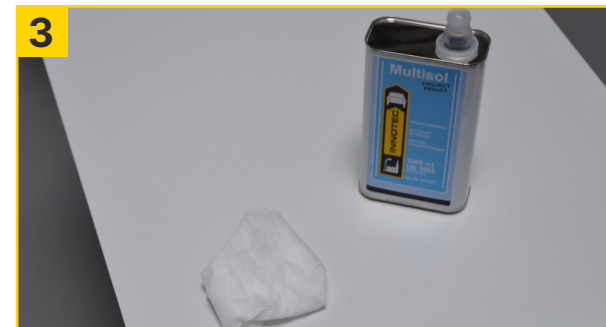
Die Fassadenplatten mit Multi Wipes Project und Multisol Project reinigen, mit einem sauberen Multi Wipes Project trocken wischen und ca. 10 Min. ablüften lassen. Falls Vorschrift, Platten grundieren!
