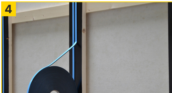
Fixation Tape Project 2 auf der Unterkonstruktion anbringen (dabei gut andrücken) und die Folie anschließend entfernen.
