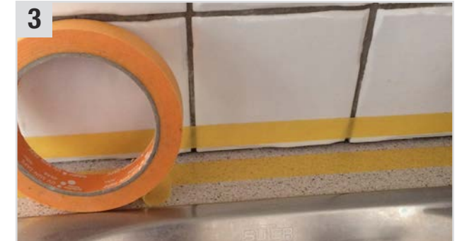
3 Die entsprechenden Stellen mit SunCore Pro (Abdeckband) abkleben.
