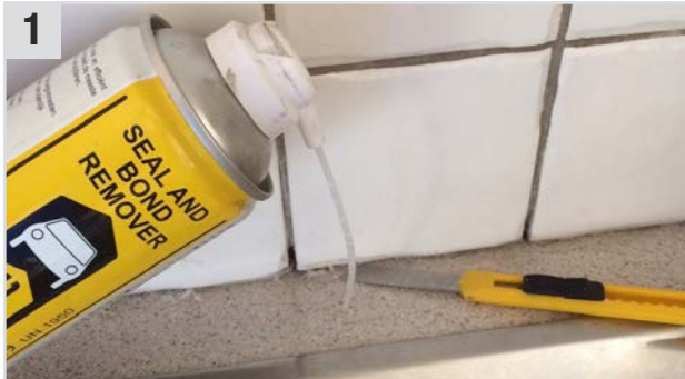
1 Alte Dichtmasse mit Seal and Bond Remover (Klebstoff- & Dichtmassenentferner) und Messer entfernen.
