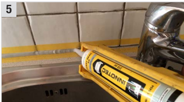
5 Easy Seal XS (Universelle Polymer-Dichtmasse) mit der Easy Grip Gun (Kartuschenpistole) an die gewünschte Stelle auftragen.
