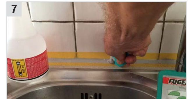
7 ... und mit einer Fugenspachtel die Dichtmasse abziehen.
