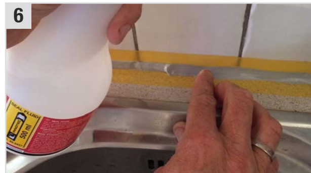
6 Anschließend mit Seal Fluid (Glättmittel) abglätten ...
