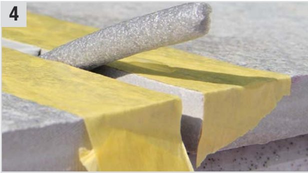
4 Back Fill Foam (Stopfschnur / Rundschnur) anbringen.
