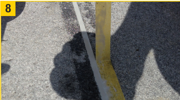
8 Zum Abschluss das SunCore Pro (Abdeckband) entfernen - Fertig!
