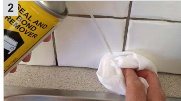
2 Anschließend mit Seal and Bond Remover (Klebstoff- & Dichtmassenentferner) und Multi Wipes (Universaltuch) die Stelle reinigen / entfetten (ca. 5 Min. ablüften lassen).
