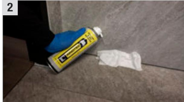
2 Mit **Seal and Bond Remover** (Klebstoff- & Dichtmassenentferner) und **Multi Wipes** (Universaltuch) die Stelle reinigen / entfetten (ca. 5 Min. ablüften lassen).
