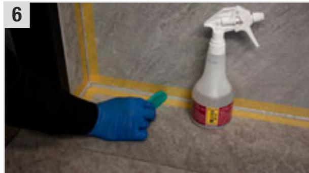
6 Anschließend **Fugenspachtel** mit **Seal Fluid** (Glättmittel) einsprühen und die Dichtmasse abziehen.
