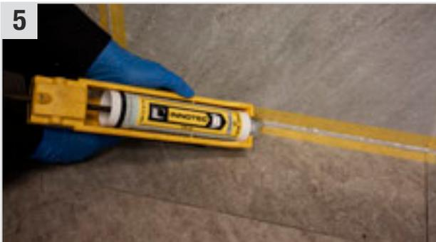
5 **Easy Seal XS** (Universelle Polymer-Dichtmasse) mit der **Easy Grip Gun** (Kartuschenpistole) an der gewünschten Stelle auftragen.
