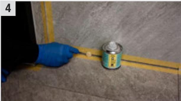
4 Um eine bessere Haftung auf heiklen Untergründen zu erzielen, eine dünne Schicht **Seal Guard** (Transparenter Primer) mit **Wollwischer** anbringen und mind. 15 Min. ablüften lassen.
