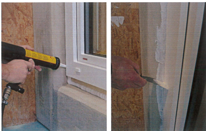
Abbildung 3: Links: Einbringen des Dichtstoffes; Rechts: Abziehen des Dichtstoffes.
