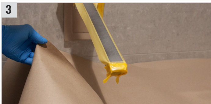
Bei Bedarf den Untergrund mit Taiga Blue Core (Abdeckpapier mit Papierklebeband) schützen.
