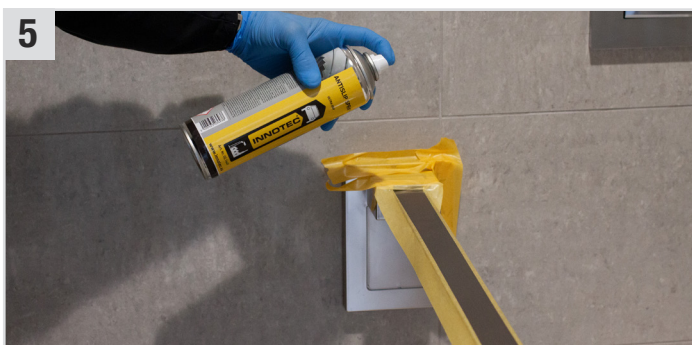
Anschließend Antislip Spray (Antirutsch-Spray) in einer geschlossenen Schicht und mit ca. 20 cm Sprühabstand aufsprühen.
