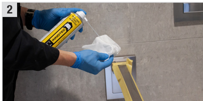
Untergrund mit Seal and Bond Remover (Klebstoff- & Dichtmassenentferner) und Multi Wipes (Universaltuch) gut reinigen und ca. 5 Min. ablüften lassen.
