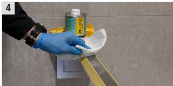
Seal Guard (Transparenter Primer) auf Multi Wipes (Universaltuch) geben und eine dünne Schicht auftragen - ca. 15 Min. ablüften lassen.
