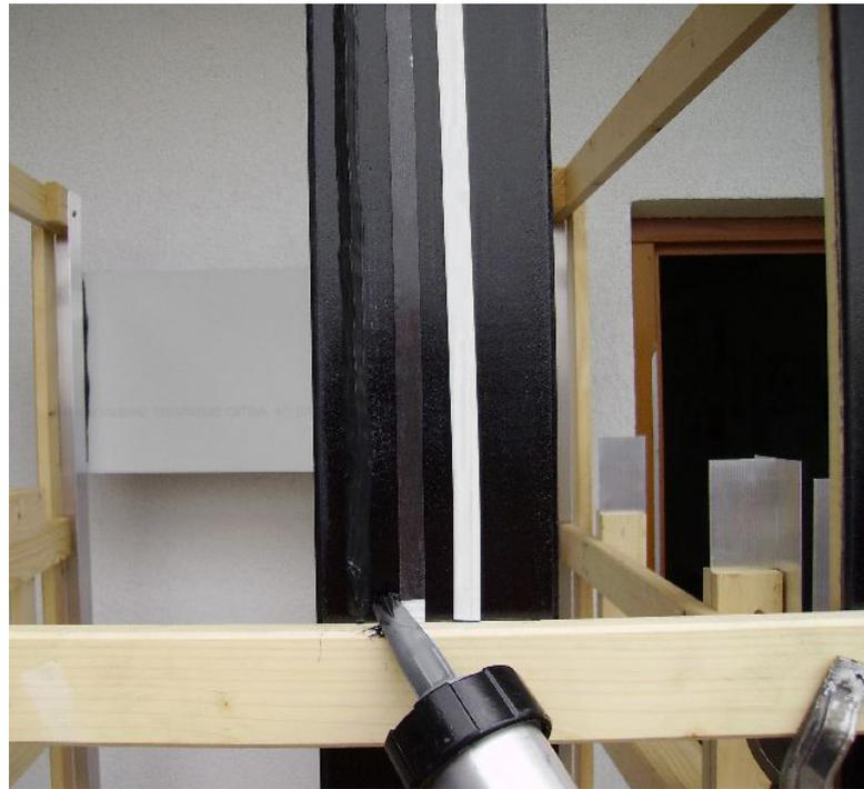
Fixation Tape Project 2 ist ein unterstützendes doppelseitiges Klebeband zur Fixierung von Fassadenplatten auf diversen Unterkonstruktionen (wie z.B. Holz) bis Adheseal Project ausreichend ausgehärtet ist und selbst die volle Klebekraft erreicht hat.
