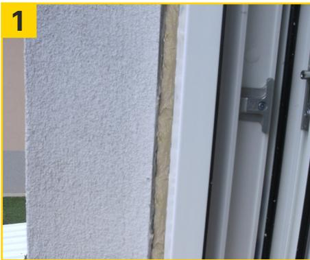
Getrockneten Montageschaum so tief herausschneiden / eindrücken bis Platz für Stopfschnur bzw. für die Dichtmasse vorhanden ist.
