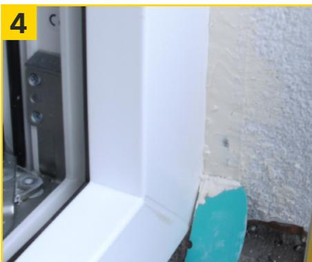
Abdeckleiste kann direkt mit Top Glass Fenster & Türen aufgeklebt werden oder Dichtmasse kann überstrichen / überputzt werden (bereits nach 60 Min.).
