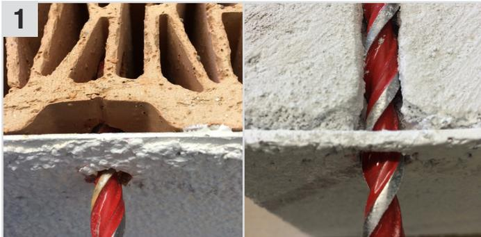
**1** In Ziegel, Ytong, Beton, Styropor etc. mit einem entsprechenden Bohrer (12 mm) ein Loch bohren.
