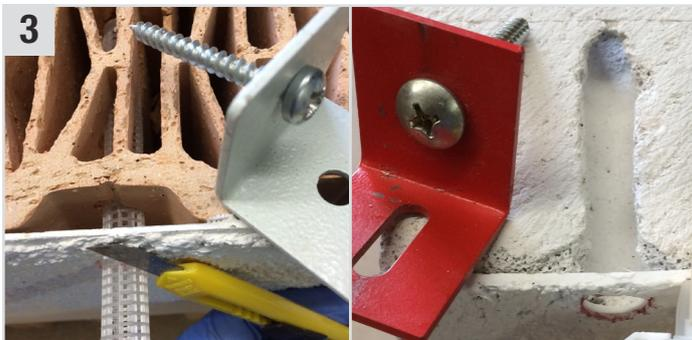
**3** Wenn notwendig **Siebhülse (12 mm)** in Bohrloch einführen und in gewünschter Länge abschneiden.
