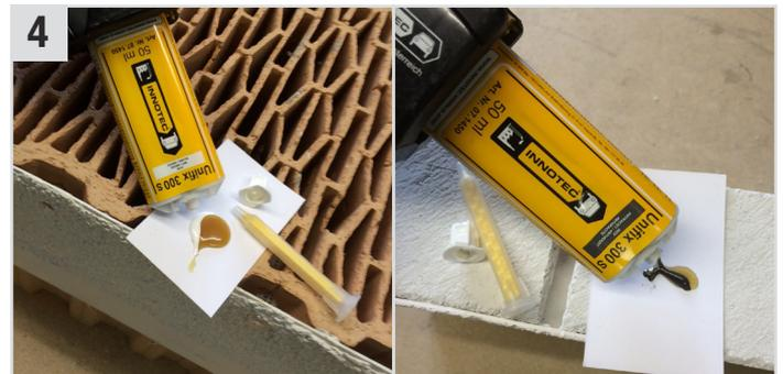
**4** Kontrolle der Funktionalität der Doppelkartusche, indem vor dem Aufsetzen der **2K-Mischdüse** mithilfe der entsprechenden **2K Pistole** Material herausgepresst wird (beide Komponenten müssen rauslaufen).
