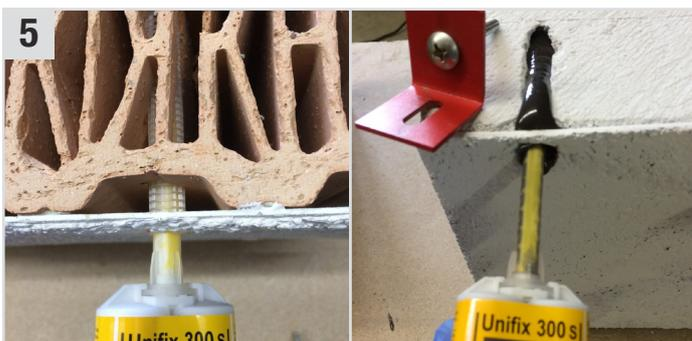
**5** Nach dem Anbringen der **2K-Mischdüse Unifix 300 S** in das Bohrloch einführen und das Material hineindrücken.
