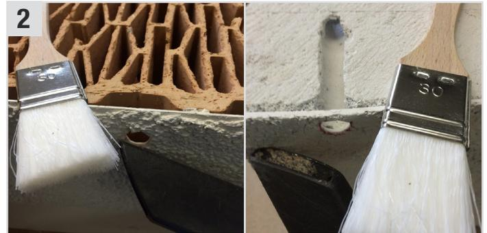
**2** Bohrloch staubfrei machen (Staubsauger, Pinsel oder wegblasen).
