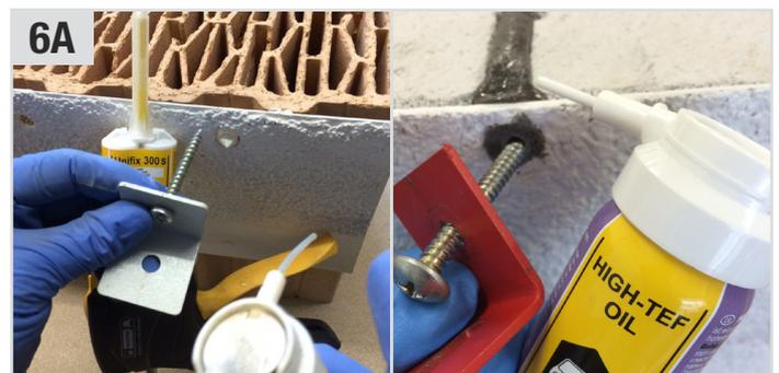
**6A** Die leicht ölige Schraube sofort und direkt in **Unifix 300 S** drücken und ca. 1-2 Min. halten / fixieren...
