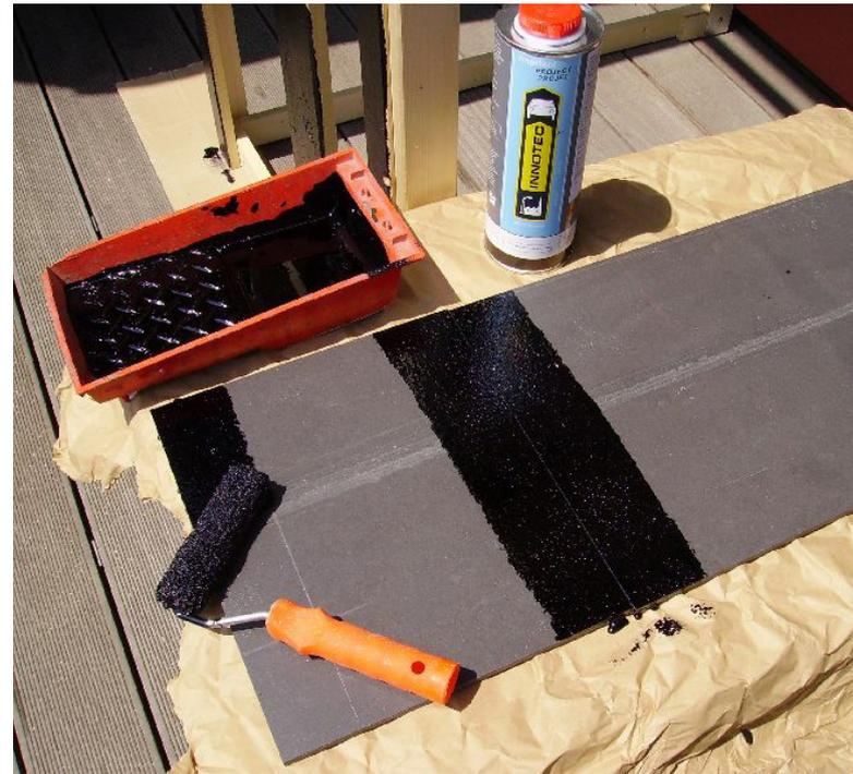
Bei der Montage von Fassadenplatten ist es enorm wichtig, die optimale Haftung zu erzielen und diese auch zu bewahren.
