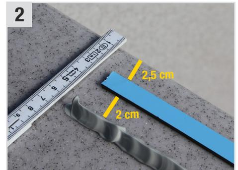
2 Fixation Tape (Doppelseitiges Klebeband) mit einem Abstand zum Wasser von 2,5 cm aufkleben. In einem weiteren Abstand von 2 cm Adheseal (Streichbare Klebedichtmasse) mit V-Form-Spitzen 8 x 8 auftragen.
