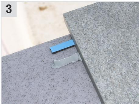
3 Steinplatte auflegen und leicht andrücken (Blaue Trägerfolie vom Fixation Tape nicht entfernen).
