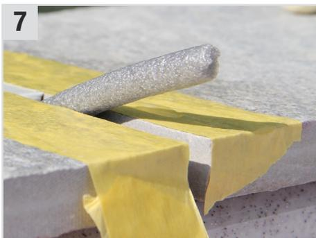
6 Die Stopfschnur/Rundschnur anbringen, Fugenseite mit SunCore Pro (Abdeckband) abkleben, dünne Schicht Seal Guard (Transparenter Primer) mit Wollwischer auftragen (ca. 15 Min. ablüften lassen)
