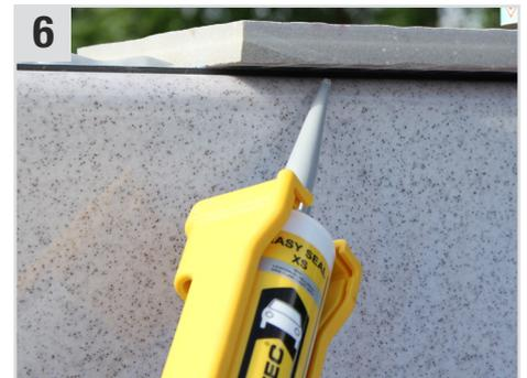
5 Danach mit Easy Seal XS (Premium Silikondichtmasse) abfugen/ausfüllen und mit Seal Fluid (Glättmittel) und Fugenspachtel abglätten. (Griff trocken: Nach ca. 10 Min. / Durchhärtung: Ca. 8 mm/Woche)
