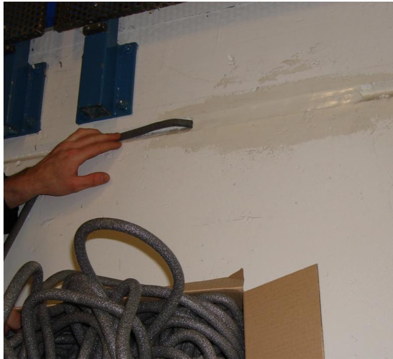
Bei Verfugungen und Abdichtungen von Nähten kommt es häufig dazu, dass das Silikon oder die Dichtmasse durch eine Dreiflankenhaftung nicht mehr ihre volle Elastizität entfalten können. Das Ergebnis sind Risse und Schäden an der Dichtmasse.
