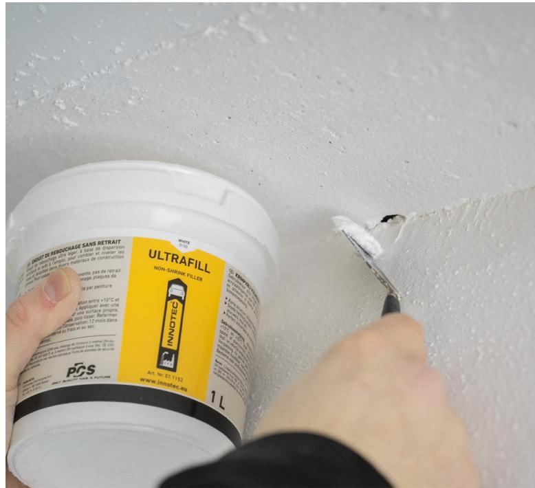
Ultrafill ist ein einzigartiges ultraleichtes Füllmittel auf Wasserbasis zum Füllen und Ausgleichen von Löchern und Rissen in verschiedenen porösen Baumaterialien in Innenräumen. Aufgrund seiner einzigartigen Zusammensetzung und kurzen Struktur schrumpft Ultrafill während der Verarbeitung nicht und ist sehr einfach und schnell anzuwenden.
