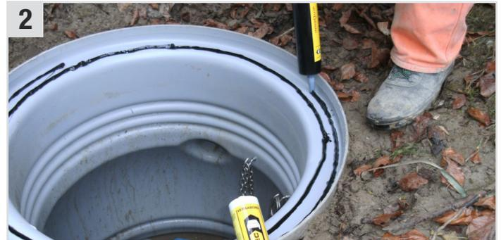
**2** Zwei Raupen **Versabond** (Abtupfbare Dichtmasse) in ▲-Form auftragen. **Tipp:** Damit eine Trennschicht erzeugt wird und somit der Kleber nicht zu sehr haftet, kann man Sand direkt auf Versabond streuen.
