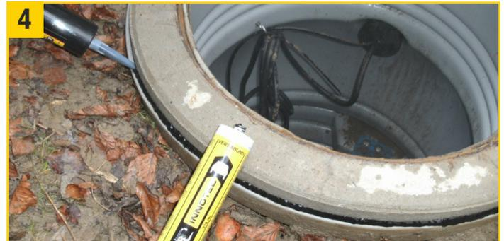
**4** Falls gewünscht oder notwendig, kann man den Spalt mit **Versabond** (Abtupfbare Dichtmasse) abdichten. **Fertig!**
