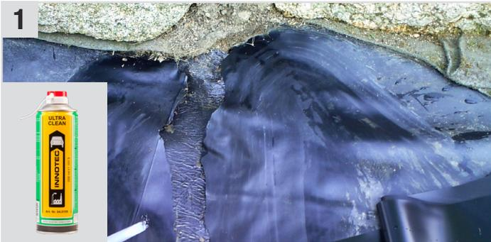
Beschädigte Folie (Klebestellen) mit **Ultra Clean** (Entfetterspray) und **Multi Wipes** (Universaltuch) reinigen/entfetten.
