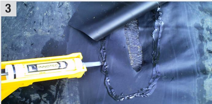
**Versabond** (Abtupfbare Dichtmasse) mithilfe der **Easy Grip Gun** (Kartuschenpistole) auftragen.
