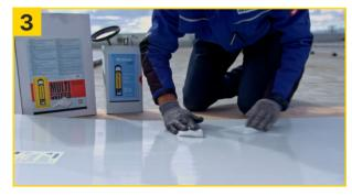
Die Rückseite des PV-Moduls mit Multisol Project und Multi Wipes Project gut reinigen und mit trockenen Multi Wipes Project nachwischen (ca. 10 Min. ablüften lassen).
