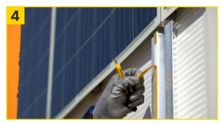
... und anschließend die Folie vom Klebeband abziehen.
