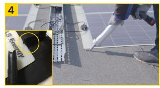
Versabond mit der Accu Silicon Pistole 10,8 V und der Beutel-Spitze (V-Form 8 × 13 mm ▲) gleichmäßig auftragen.
