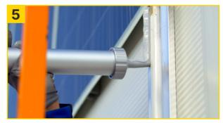
Adheseal Project mit der Accu Silicon Pistole 10,8 V und der Beutel-Spitze (V-Form 8 × 13 mm ▲) parallel entlang der beiden Klebebänder-Streifen in einem Abstand von ca. 1 cm auftragen.
