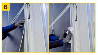
Das PV-Modul innerhalb von 10 Min. vorsichtig auf die Kleberaupen legen & mittels Multi Wipes Project an den Klebestellen andrücken (punktuelle Belastungen sollen aufgrund von Zellenbrüchen vermieden werden).
