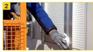
Unterkonstruktion mit Multisol Project und Multi Wipes Project gut reinigen und mit trockenem Multi Wipes Project nachwischen (ca. 10 Min. ablüften lassen).
