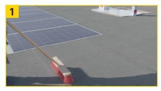
Besandete Bitumen: Das lose Material mit Besen entfernen. Glatte Bitumen: Untergrund mit Multisol Project & Multi Wipes Project reinigen.
