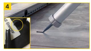
Versabond mit der Accu Silicon Pistole 10,8 V und der Beutel-Spitze (V-Form 8 × 13 mm ▲) gleichmäßig entlang der gereinigten Bahnen auftragen.
