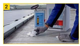
Klebebahnen mit Multisol Project und Multi Wipes Project gut reinigen und mit trockenen Multi Wipes Project nachwischen (ca. 10 Min. ablüften lassen).
