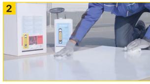
Die Rückseite des PV-Moduls mit Multisol Project und Multi Wipes Project gut reinigen und mit trockenen Multi Wipes Project nachwischen (ca. 10 Min. ablüften lassen).
