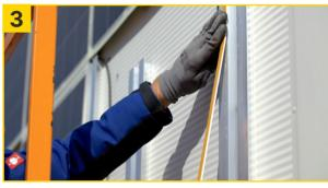
PE-Schaumklebeband Project der Längsseite entsprechend anbringen, gut andrücken ...
