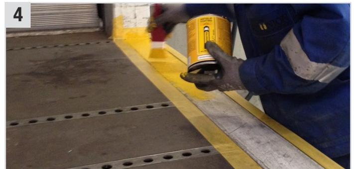
4 **Antislip Coating** (Antirutsch-Beschichtung) mithilfe der **Kyoto Car Black** (Karo Kunststoff-Spachtel) oder mit unserem **Brush 30 mm** (Spezial-Pinsel) auftragen.
