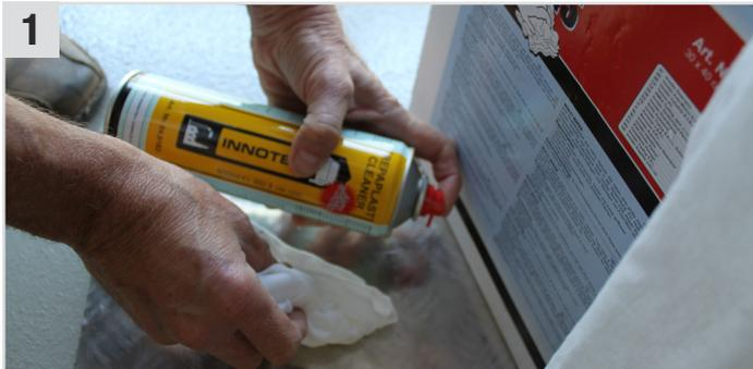
1 Alu-Untergrund mit **Repaplast Cleaner Antistatic** (Kunststoff-Reiniger) und **Multi Wipes** (Universaltuch) gut reinigen (ca. 5 Min. ablüften lassen).
