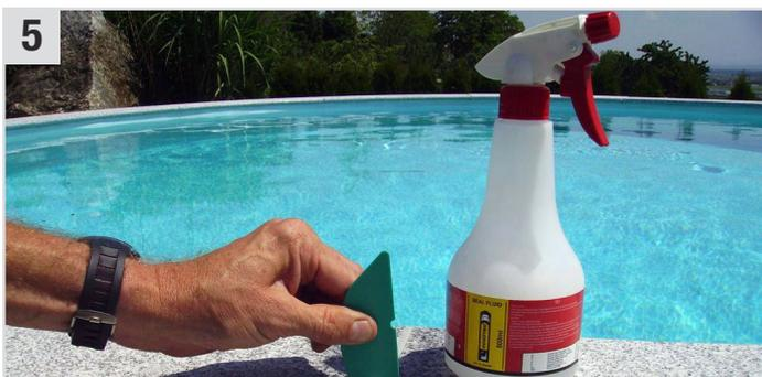
**Easy Seal XS** (Universelle Polymer-Dichtmasse) mit **Seal Fluid** (Glättmittel) und **Fugenspachtel** glätten und abziehen
