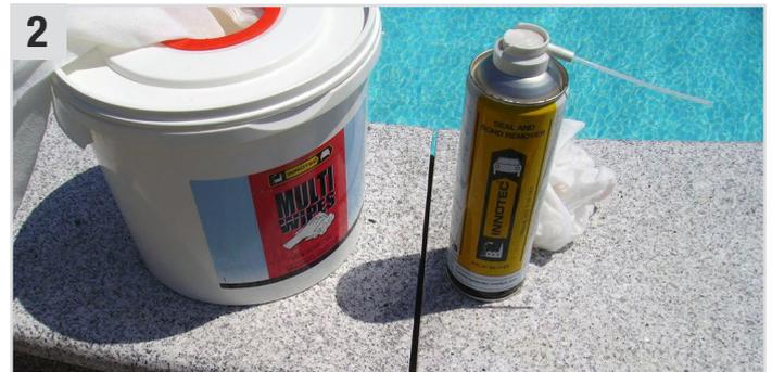
Entfetten der Flächen mit **Seal and Bond Remover** (Klebstoff- & Dichtmassenentferner) und mit einem **Multi Wipes Tuch** (Universaltuch) trocken wischen - Abluftzeit von 10 Min. beachten!
