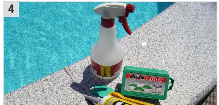
**Easy Seal XS** (Universelle Polymer-Dichtmasse) mithilfe der **Easy Grip Gun** (Kartuschenpistole) auftragen (Achtung: Hautbildung nach ca. 10 Minuten!)
