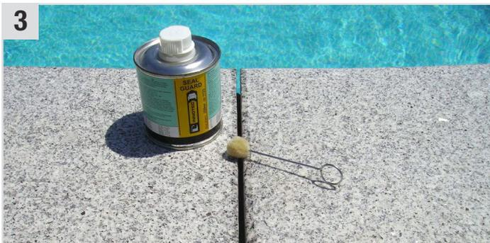
Fuge mit **Seal Guard** (Transparenter Primer) behandeln (Tipp: Mithilfe eines **Wollwischers**) und ca. 15 Minuten ablüften lassen
