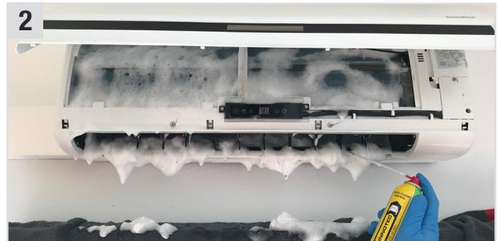
2 Ein Tuch unterlegen und **Airco Clean Control** (Klimaanlagen-Reiniger) mithilfe der Sonde am Verdampfer anbringen und mind. 15 Min. einwirken lassen.
