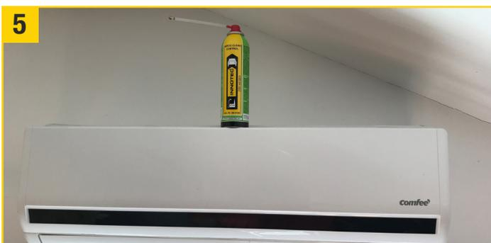
5 Für ein optimales Ergebnis das Klimaanlagen-System erst nach einigen Stunden wieder benutzen (bildet eine pilzhemmende Schutzschicht gegen erneute Verschmutzungen). **Fertig!**
