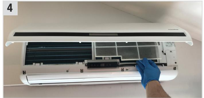
4 Abdeckungen und Klimaanlagen-Komponenten wieder montieren und Gebläse für 5 Minuten auf schwacher Stufe laufen lassen.
