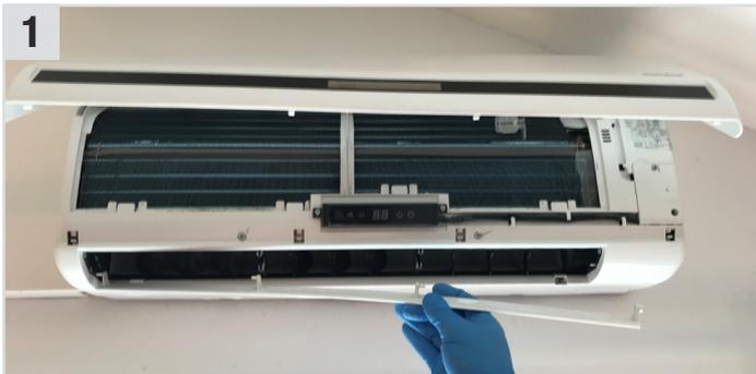
1 Das Klimaanlagen-System einige Minuten vor der Behandlung ausschalten, damit der Verdampfer nicht mehr kalt/feucht ist. Abdeckungen und Klimaanlagen-Komponenten entfernen.
