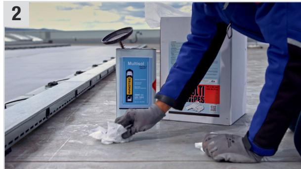
2 Klebebahnen mit mit **Multisol** (Entfetter / Reiniger) und **Multi Wipes** (Universaltuch) gut reinigen und mit trockenen **Multi Wipes** nachwischen (ca. 10 Min. ablüften lassen).
