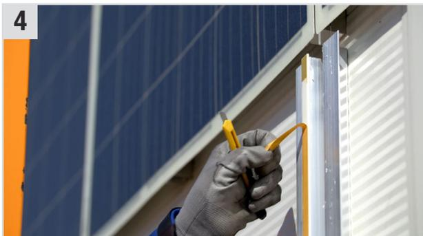
4 ... und anschließend die Folie vom Klebeband abziehen.
