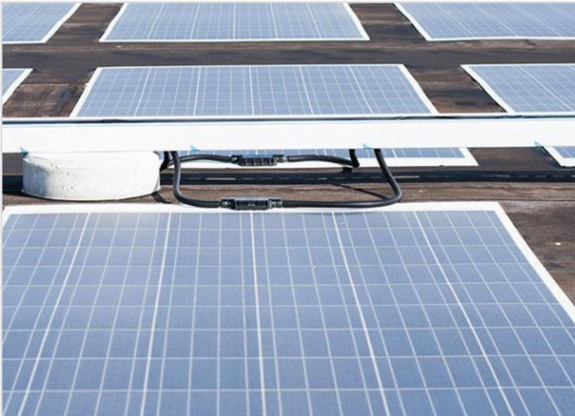
Der Kabelkanal soll mittels Abstandshaltern (Betonplatten, Bautenschutzmatte, oder Ähnliches) distanziert von der Dachbahn angebracht werden (siehe Foto links), damit das Regenwasser ungehindert ablaufen kann.
