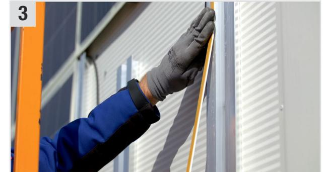
3 **PE-Schaumklebeband 12 x 3 mm** der Längsseite entsprechend anbringen, gut andrücken ...
