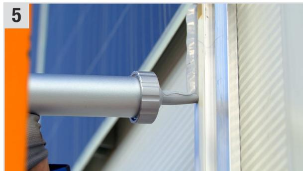
5 **Adheseal Grau** mit der **Accu Silicon Pistole 10,8 V** (Akku-Pistole) und der **Beutel-Spitze** (V-Form 8 x 8 mm ▲) parallel entlang der beiden Klebebander-Streifen in einem Abstand von ca. 1 cm auftragen.
