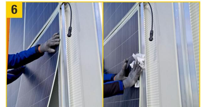
6 Das Photovoltaik-Modul innerhalb von 10 Min. vorsichtig auf die Kleberaupen legen und dann mittels **Multi Wipes** (Universaltuch) an den Klebestellen andrücken (punktuelle Belastungen sollen vermieden werden, da ansonsten Zellenbrüche entstehen können). **Fertig!**
