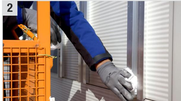
2 Unterkonstruktion mit **Multisol** (Entfetter / Reiniger) und **Multi Wipes** (Universaltuch) gut reinigen und mit trockenem **Multi Wipes** nachwischen (ca. 10 Min. ablüften lassen).
