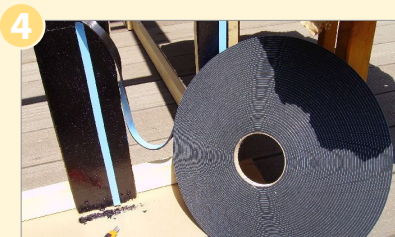
Klebeband anbringen Fixation Tape 3 auf der Unterkonstruktion anbringen (dabei gut andrücken) und die Folie anschließend entfernen.
