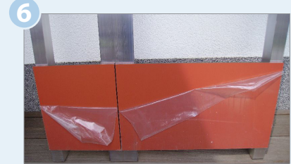
Montage-Abschluss Sollte aus Versehen Adheseal Project auf die Vorderseite der Platte gelangt sein, diese am Besten sofort mit Multisol Project und Multi Wipes Box Project reinigen.
