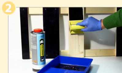
Grundierung anbringen Imprisol Project Grundierung auf die Holz-Unterkonstruktion auftragen und anschließend 10 Minuten ablüften lassen.
