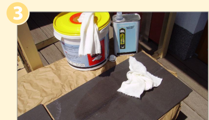
Reinigung der Platten Die Fassaden-Platten mit Multi Wipes Box Project und Multisol Project reinigen und mind. 5 Minuten ablüften lassen. Falls Vorschrift, Platten grundieren!
