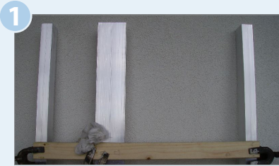
Alu-Unterkonstruktion Achs-Abstand 40 - 50 cm!
