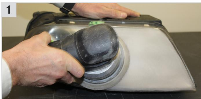
**1** Steinschläge, Kratzer und/oder vergilbte UV-Beschichtung kompl. entfernen: Mit Excenterschleifer je nach Beschädigung / Vergilbung mit K 500, K 600, K 800, K 1000, K 2000 trocken und nass schleifen.
