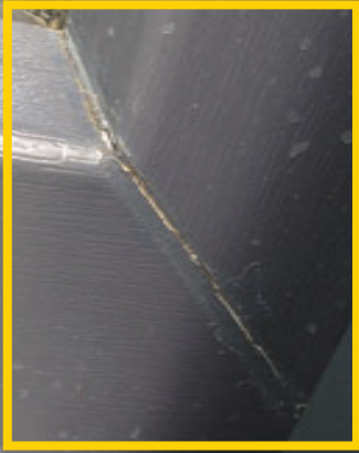
Reparatur von Spannungsriss
