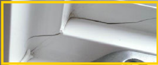
Reparatur von Spannungsriss
