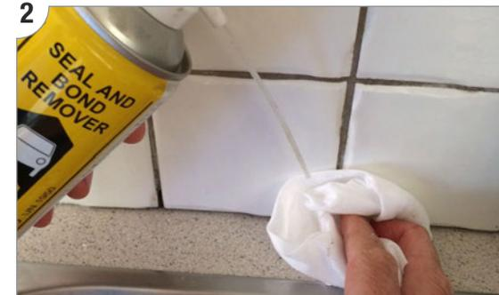
2 Anschließend mit **Seal and Bond Remover** (Klebstoff- & Dichtmassenentferner) und **Multi Wipes Box** (Universaltuch) die Stelle reinigen / entfetten (ca. 5 Min. ablüften lassen)
