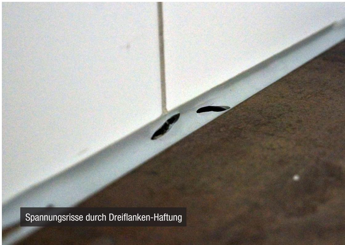
Spannungsrisse durch Dreiflanken-Haftung
