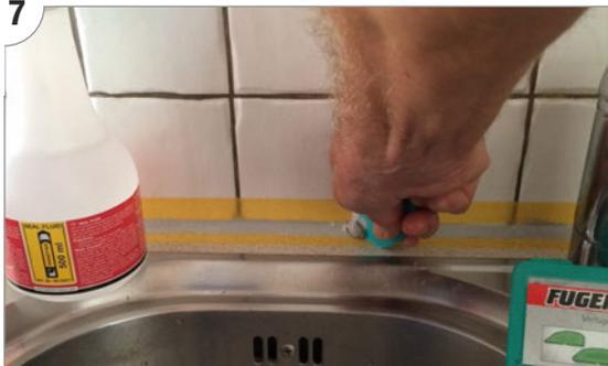
... und mit dem **Fugenspachtel-Set** die Dichtmasse abziehen
