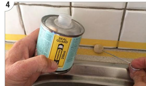
4 Falls benötigt: Die Fuge mit **Seal Guard** (Transparenter Primer) behandeln (Tipp: **Wollwischer** für ein sauberes Auftragen verwenden)
