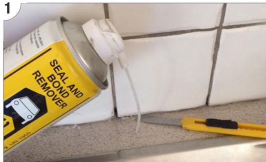
1 Alte Dichtmasse mit **Seal and Bond Remover** (Klebstoff- & Dichtmassenentferner) und Messer entfernen
