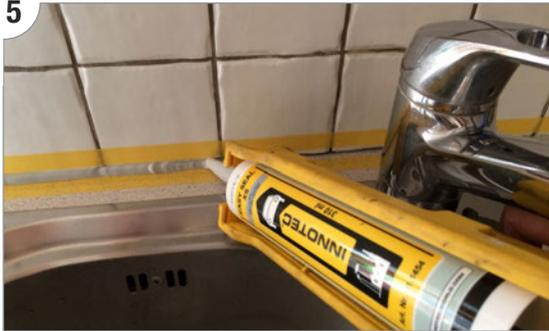
**Easy Seal XS** (Universelle Polymer-Dichtmasse) mit Hilfe der **Easy Grip Gun** (Kartuschenpistole) an die gewünschte Stelle auftragen
